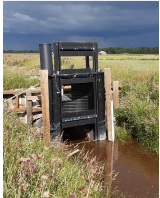
SB Dam asennettiin vuonna 2018. Kuva: A. Bonde
